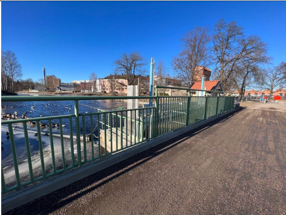
Figur 11. Inloppet från ovan, notera det något förhöjda räcket ovanför inloppet och att det med enkelhet går att gå runt detta.
