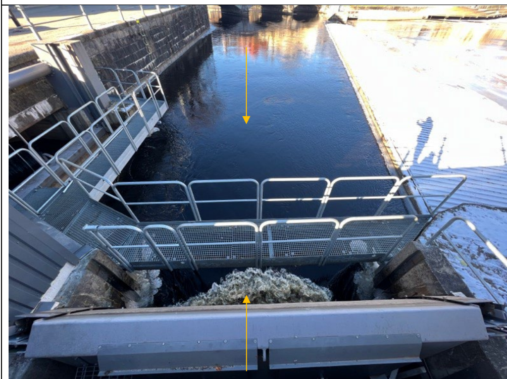
Figur 10. Inloppet till samma plats som i Figur 9, det strömmande vattnet lättillgängligt för den som står ovanpå bron (nedre pilen). Ytplacerad och flytande barriär som täcker inloppet för den som hamnat i vattnet och som skulle kunna användas för att hålla fast sig i saknas (övre pil).
