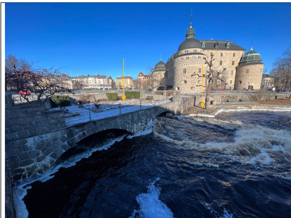
Figur 9. Utlopp av strömmande vatten vid Kvarnbron. Örebro slott i bakgrunden. Notera ytan markerad med pil belägen ovanför utloppet, samt kajen precis bredvid utloppet, där skaderiskerna är extra höga i och med den enkla accessen till det strömmande vattnet.
